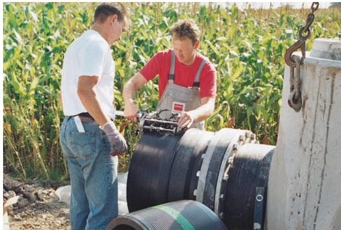
Устройство для снятия оксидного слоя FRIATOOLS FWSG 710 S для патрубков и труб диаметром d 250-710 мм..
